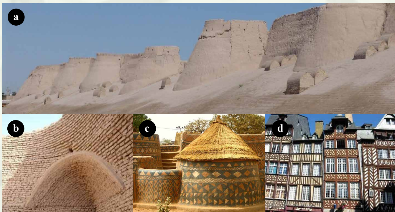
Fig. 3 - Varie tipologie del costruire in terra, a) Rammed earth, Uzbekistan, Khiva; b) Adobe, Cina Gaochang; c) Massone, Mali; d) Doubled earth, Olanda (fotografie M. Coli).
